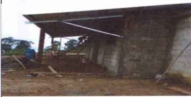
Foto2: Terminada la sustitucion de paredes de aula.
