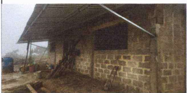
Foto 3: Así luce la sustitucion del techo de aulas .
