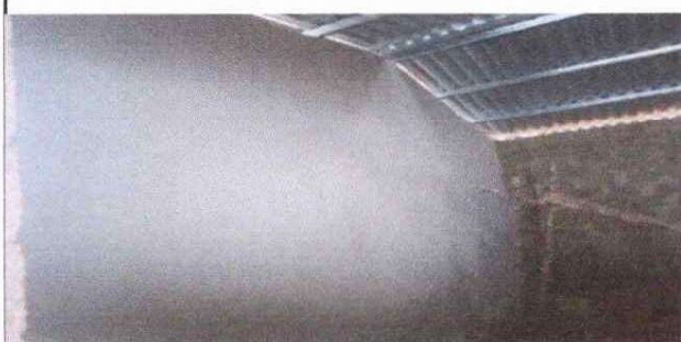
Foto1: Así luce la sustitucion de las paredes de aula.
