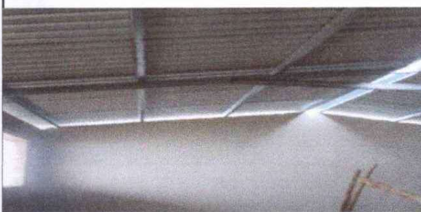
Foto 4: sustitucion de pared y techo.
